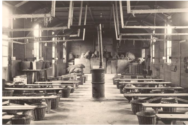
Atelier de récupération de fils et de ficelles du camp de Jargeau (mars 1942) (Archives du Loiret 175 W 34101)
